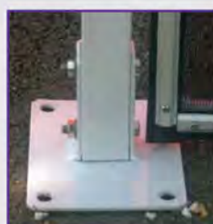
FIXAÇÃO POSTERIOR DE PORTA
